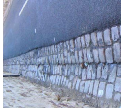
Caniveau en pavés dans une rue étroite (Wy-dit-Joli-Village, 95)
